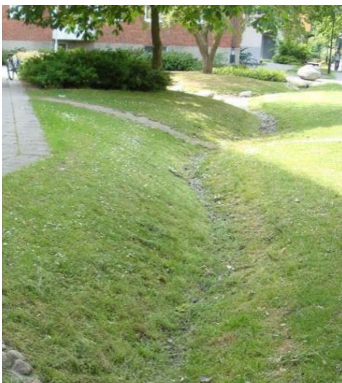
Figur 18. Svackdike (Foto: Sweco)
